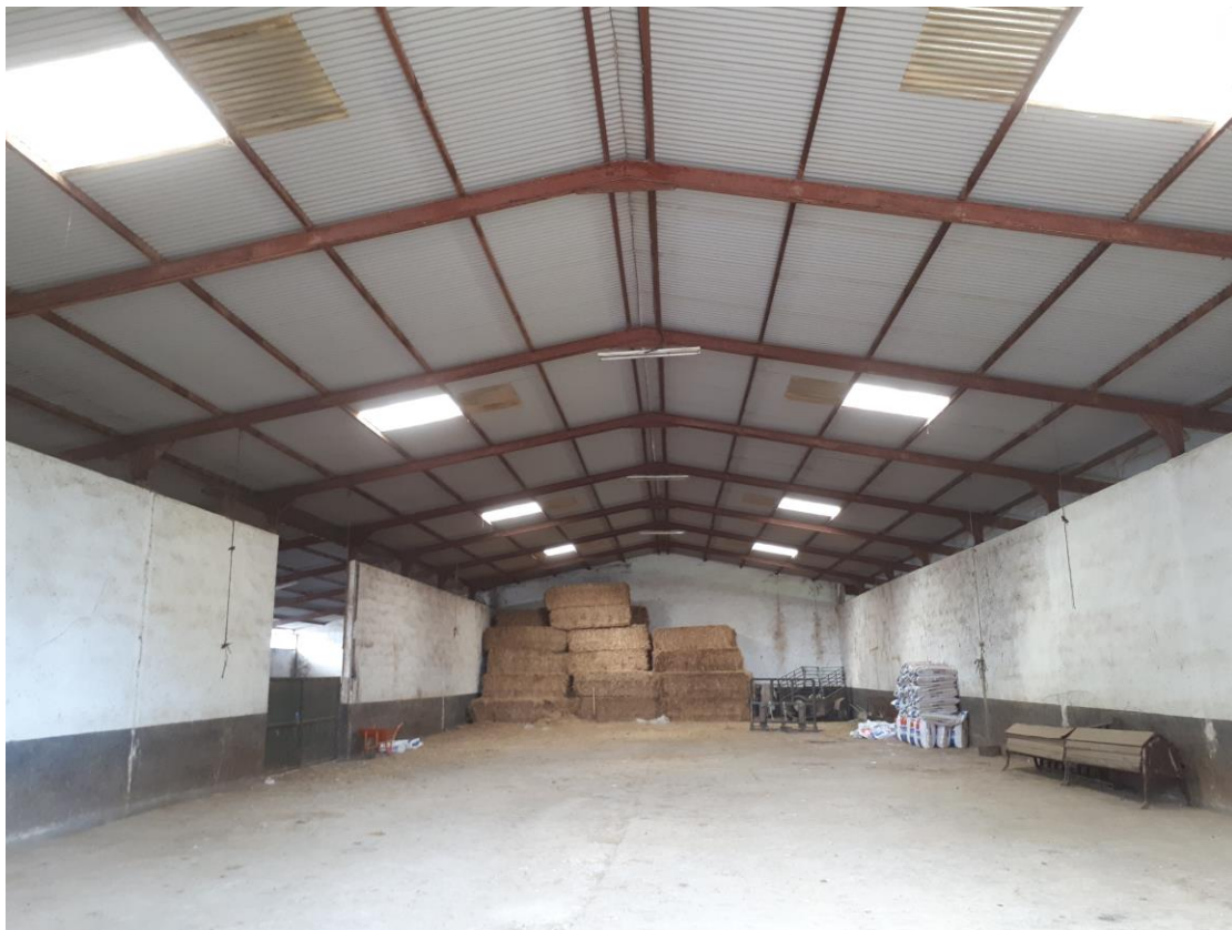
Foto 3: Interior de la nave de secuestro.
