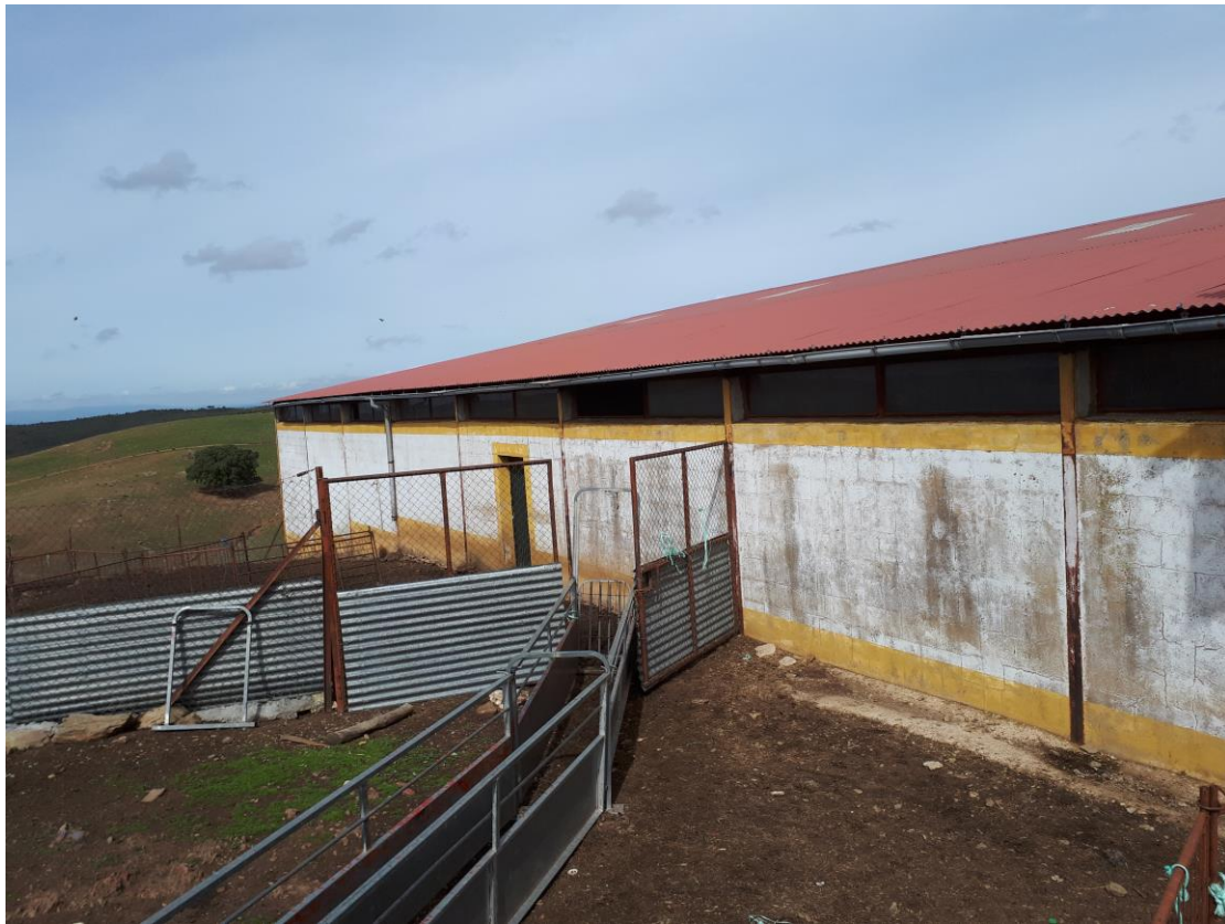
Foto 7: Alzado lateral sur de la nave de secuestro.
