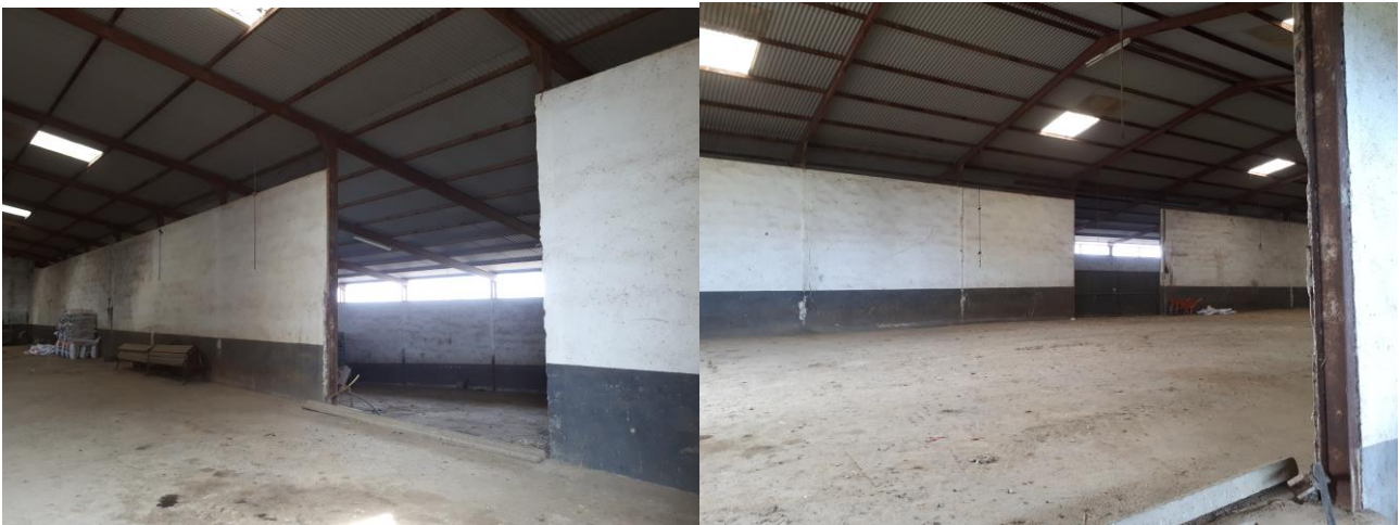
Foto 5 y 6: Huecos de separación de las estancias interiores de la nave de secuestro.
