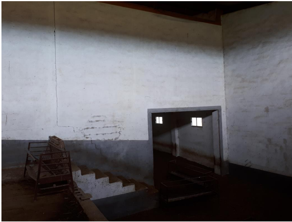
Foto 11: Acceso interior del lazareto.
