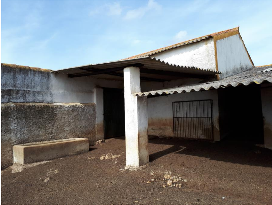
Foto 23: Accesos al interior del patio.
