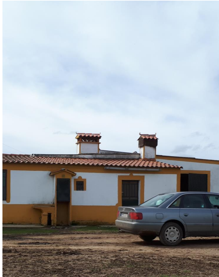
Foto 18: Construcción despensa /almacén.
