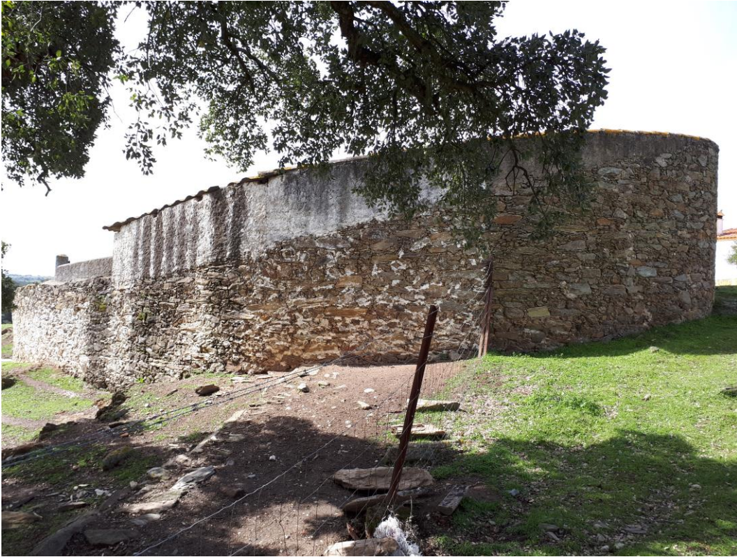
Foto 25: Cerramiento perimetral del patio de piedra.
