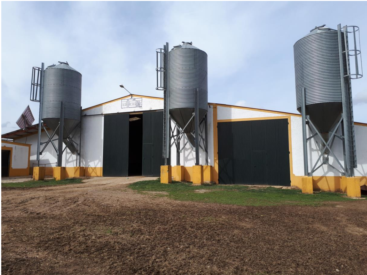
Foto 1: Alzado principal de acceso a la nave de secuestro.
