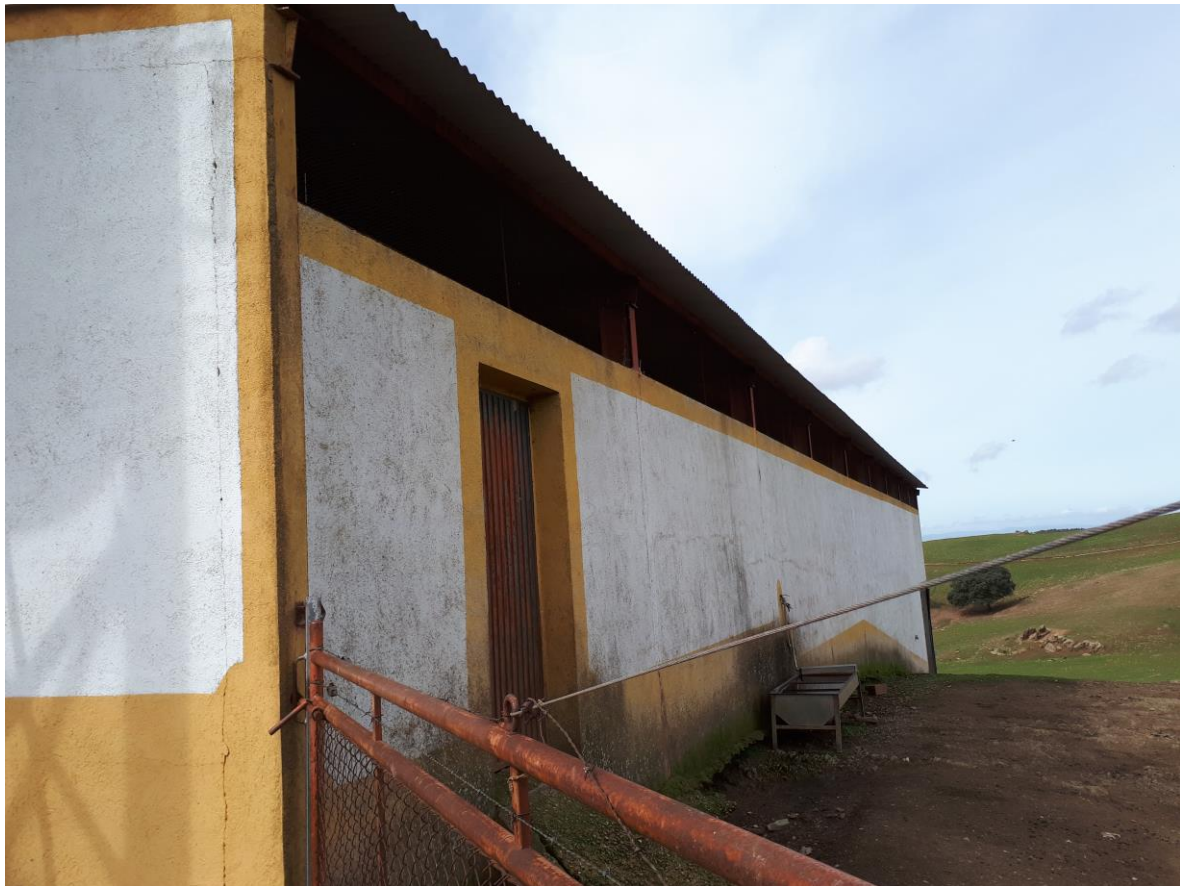
Foto 2: Alzado lateral norte de la nave de secuestro, donde se aprecia la tela pajarera en huecos.
