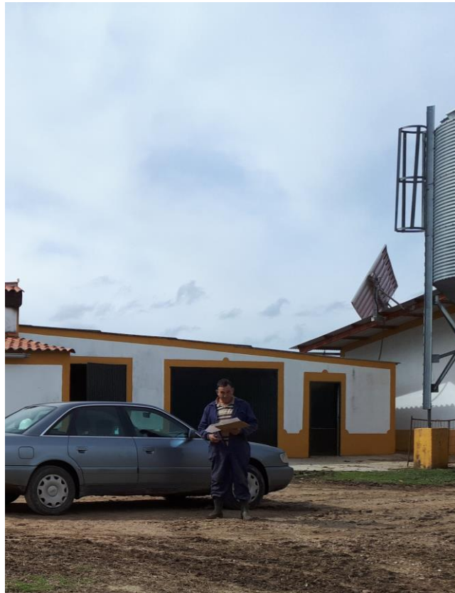
Foto 19: Fachada de acceso a la nave II cochera.
