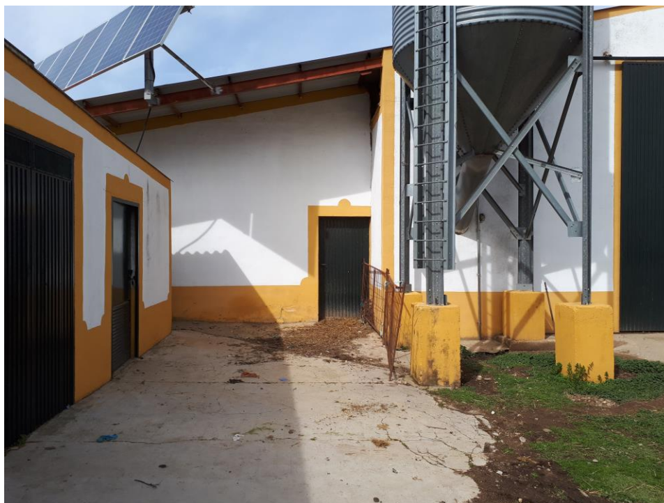
Foto 20: Vista alzado principal nave de secuestro y alzado principal nave cochera.
