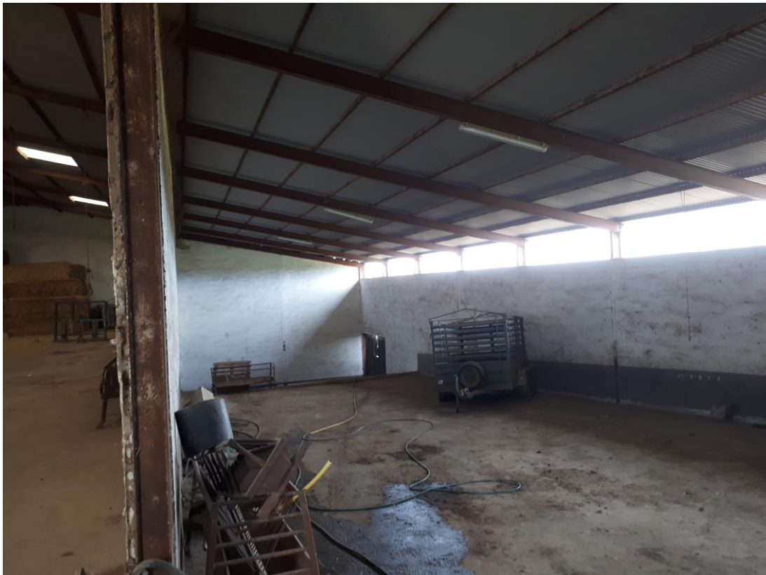
Foto 4: Interior de la nave de secuestro.
