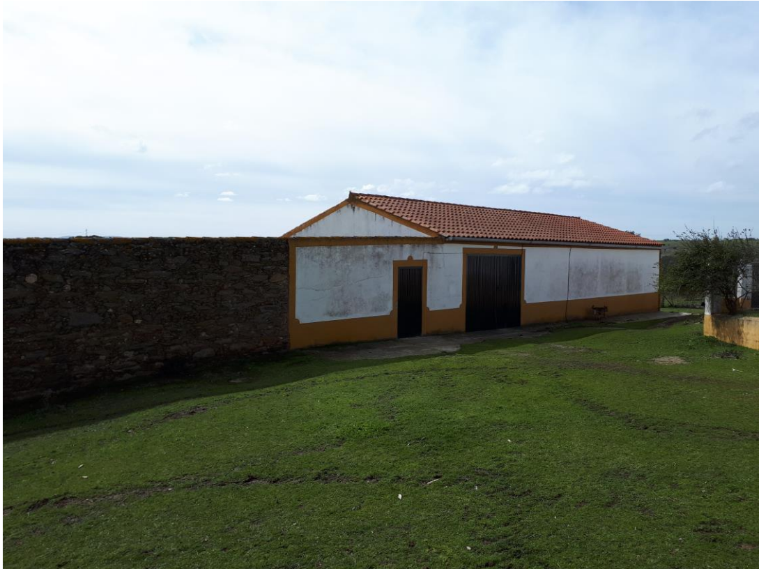
Foto 21: Alzado norte de la nave III para ganado y del cerramiento del patio.
