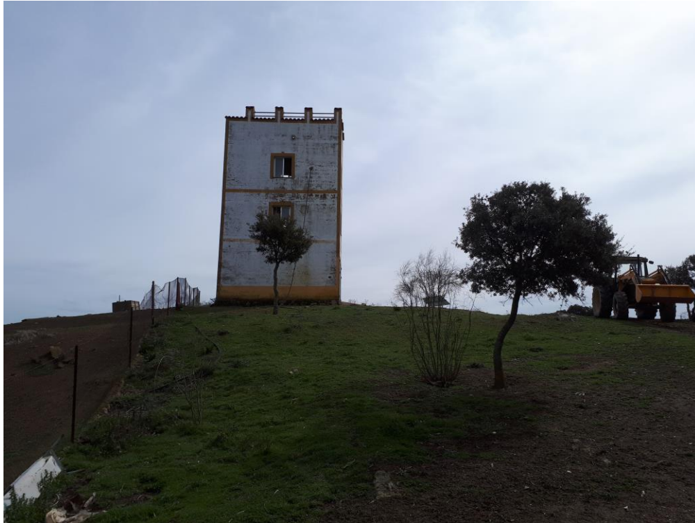
Foto 17: Construcción del depósito.
